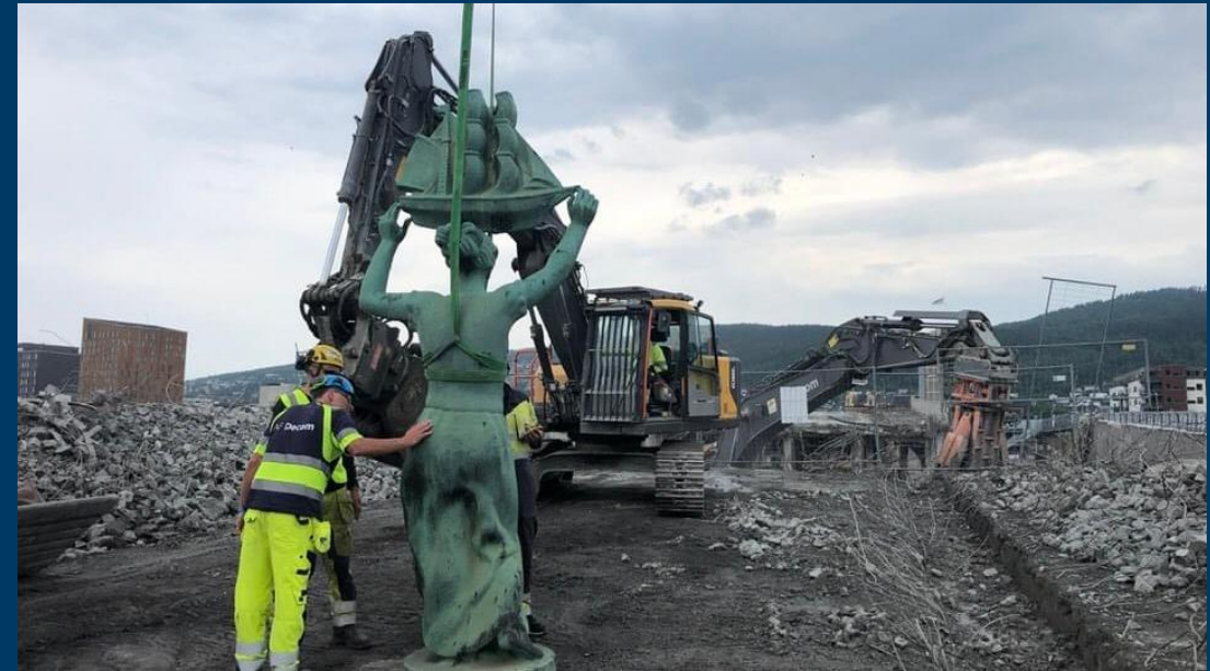
18. mai 2022: Brua stengt, oppstart riving.
